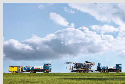
Energi- och brunnborrning med dotterbolaget BauGrund Süd, Bad Wurzach
